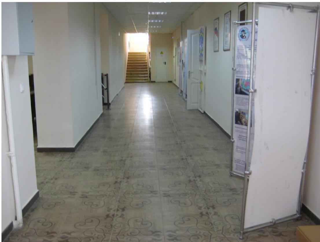
Фото 6. Коридор первого этажа.
