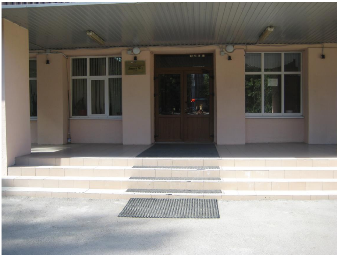
Фото 4. Вход в МБОУ Лицей № 1.
